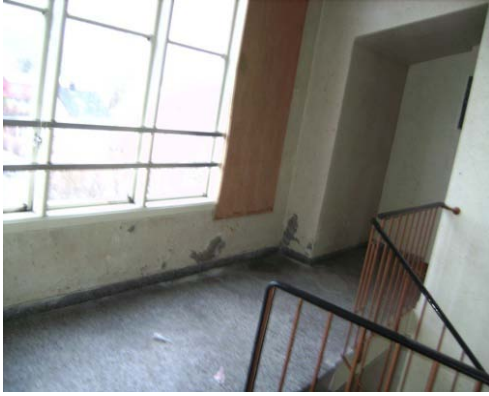
Dalegata før oppgradering. Trappeoppgang
